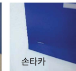
수성 페인트 마감인 5.5mm 합판으로 되어있어 압정 시공용이
