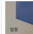
수성 페인트 마감인 5.5mm 합판으로 되어있어 압정 시공용이
